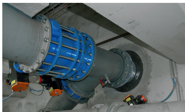
Rohrleitungen am Zu- bzw. Ablauf – sanierte Rohrleitungen am Filterbecken
